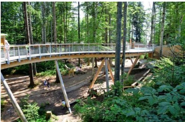
Die Holz-Stahl-Konstruktion ist über 500m lang und schlängelt sich auf Höhen von 3 –
